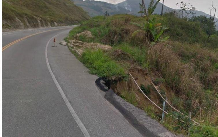
**Figura 28.** Curva acentuada com desmoronamento de pista à direita - sentido Santos - Rio de Janeiro - km 462
