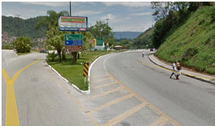
**Figura 64.** Marcador de perigo e placa em desacordo com o CTB no 478
