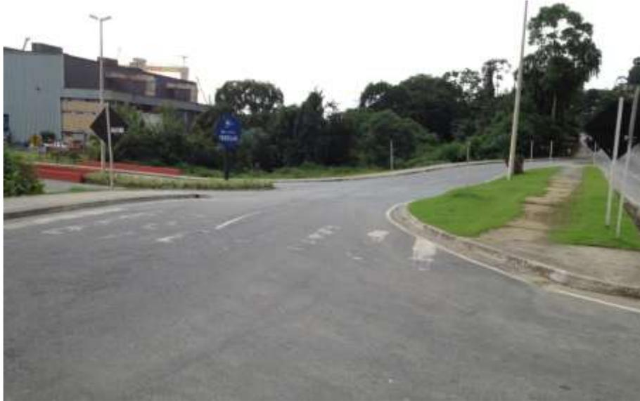
**Figura 115.** Faixa de travessia de pedestre desgastada no km 469
