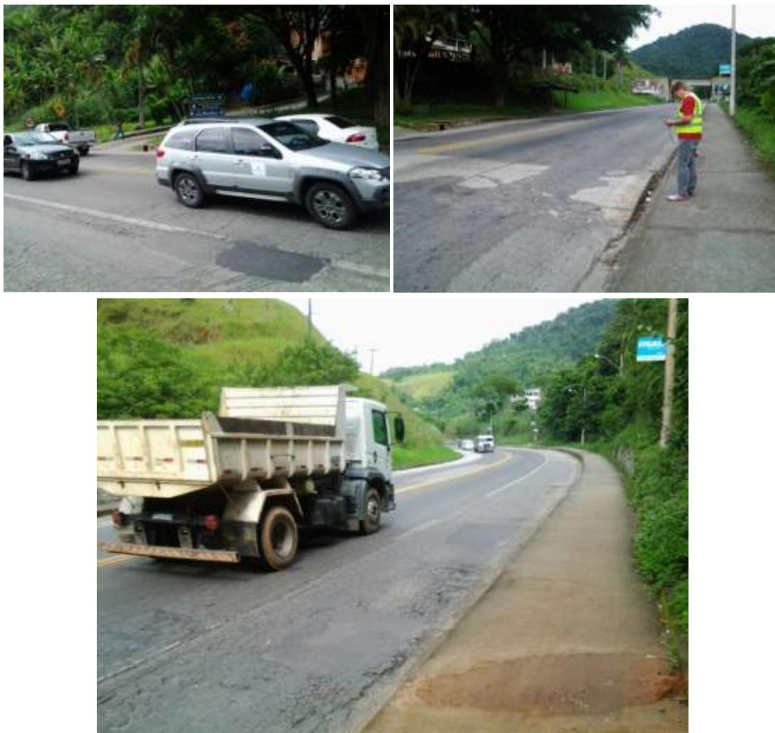
**Figura 101.** Condição do pavimento em degradação do km 480
