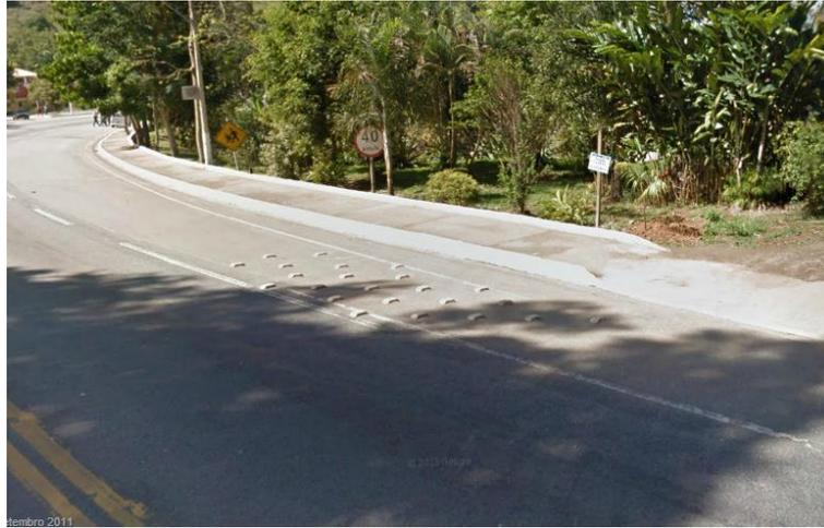
**Figura 48.** Tachões em locais inadequados no km 473
