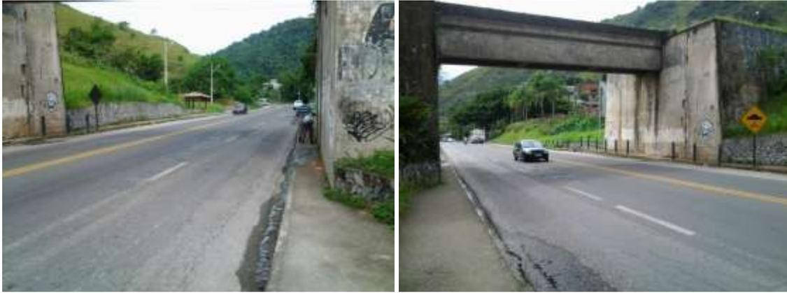
**Figura 100.** Passagem inadequada para pedestres no km 480
