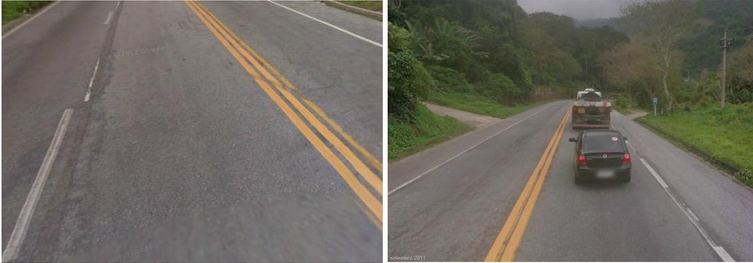
**Figura 24.** Sinalização horizontal antiga não removida e desgastada – km 462
