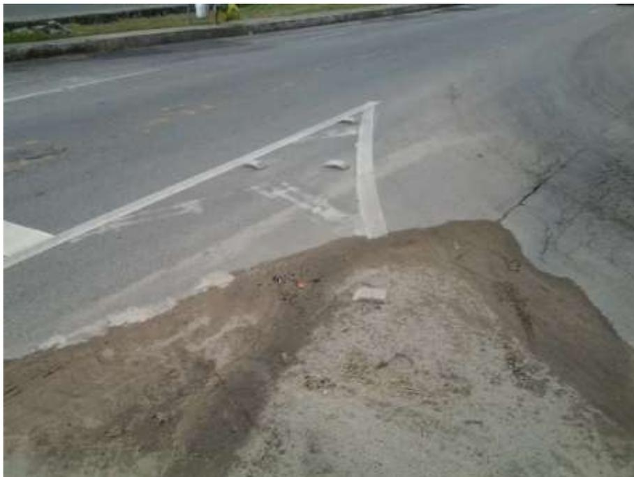
**Figura 86.** Presença de material solto na pista do km 481
