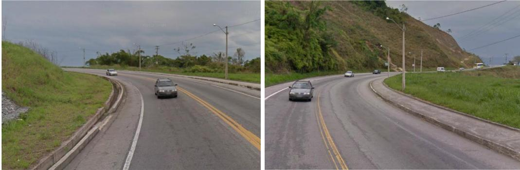
**Figura 39.** Sinalização horizontal desgastada e não remoção da pintura antiga no km 472
