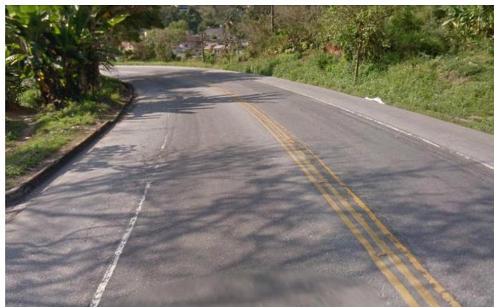
**Figura 31.** Sinalização horizontal desgastada e não remoção da pintura antiga no km 468
