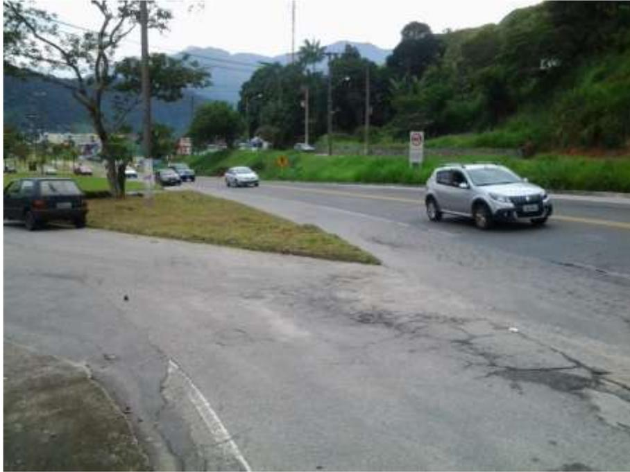
**Figura 87.** Inexistência de faixa de aceleração e sinalização no km 481
