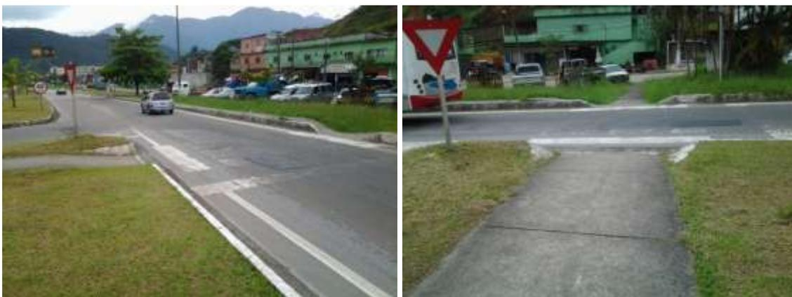
**Figura 79.** Faixa de travessia de pedestres desgastada no km 481
