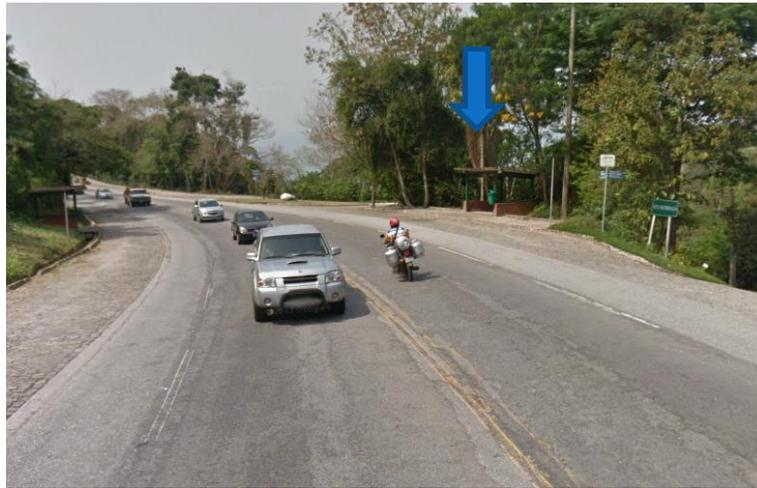
**Figura 50.** Sinalização horizontal desgastada e não remoção da pintura antiga no km 476
