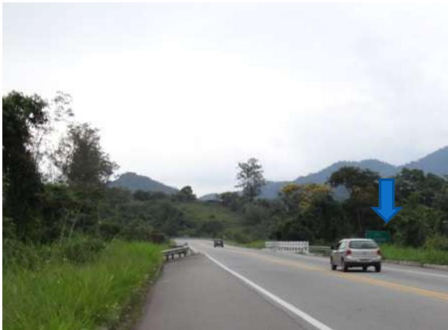
**Figura 179.** Ponte sem marcadores de obstáculo e vegetação alta no km 494
