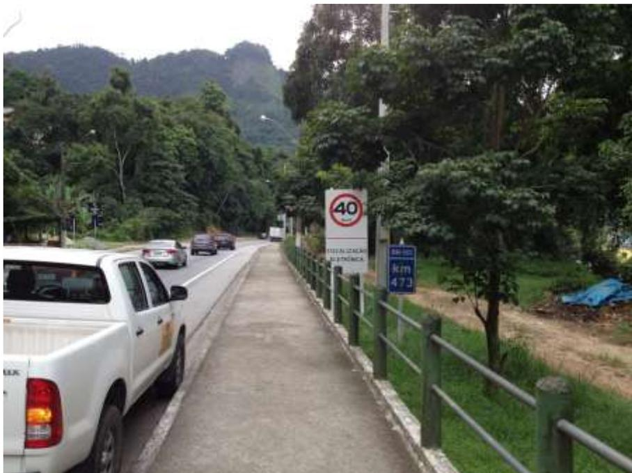
**Figura 175.** Placas de sinalização parcialmente obstruídas no km 473
