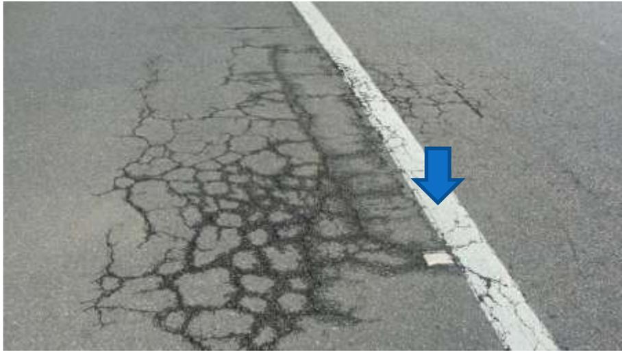
**Figura 174.** Defeitos no pavimento do km 537
