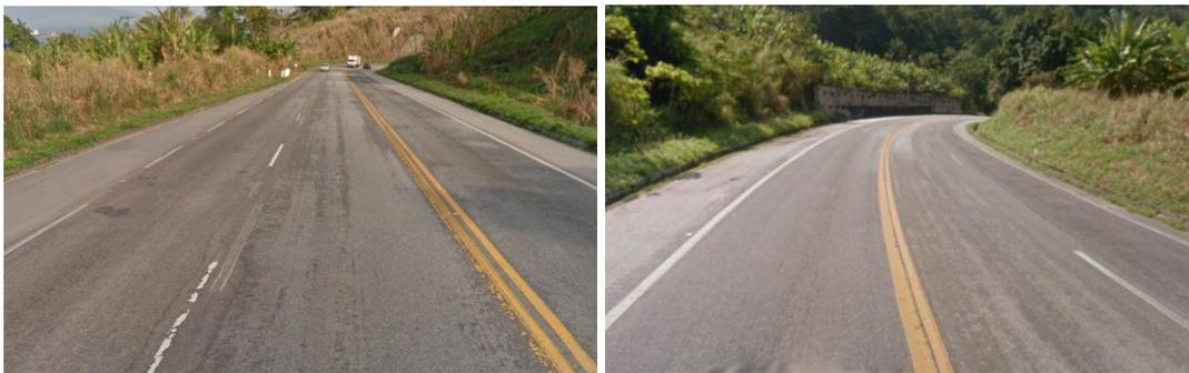
**Figura 19.** Desgaste na sinalização horizontal – km 439
