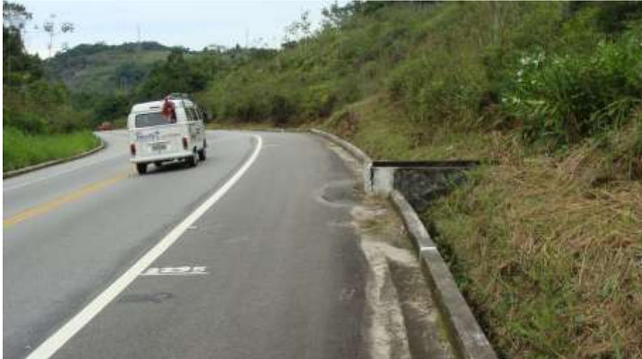
**Figura 148.** Drenagem deslocada em função de um deslizamento no km 528
