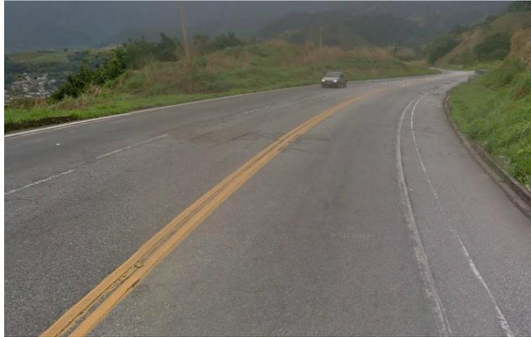
Figura 22. Sinalização horizontal desgastada e não remoção da pintura antiga – km 460
