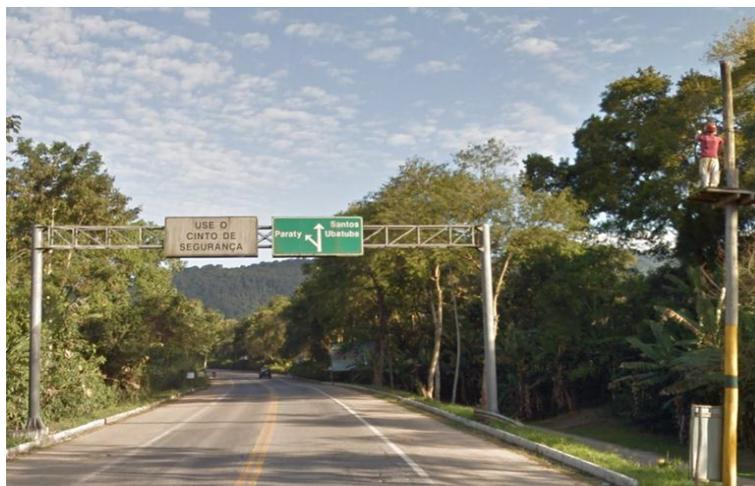
**Figura 124.** Obstáculos fixos sem proteção – km 571
