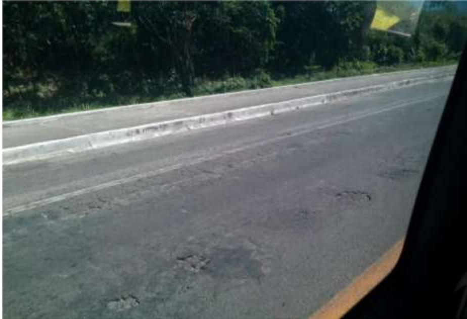
**Figura 7.** Exemplo de condição física do trecho, com presença de área de acostamento e calçada elevada para pedestres
