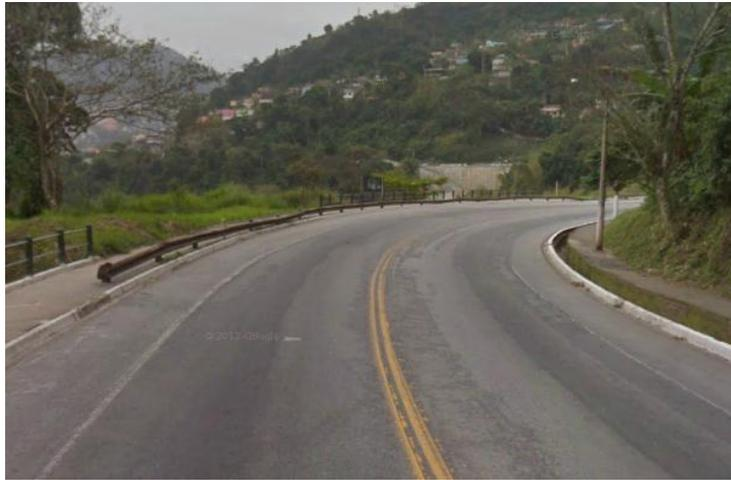
**Figura 57.**Sinalização horizontal desgastada e falta de sinalização vertical no km 477
