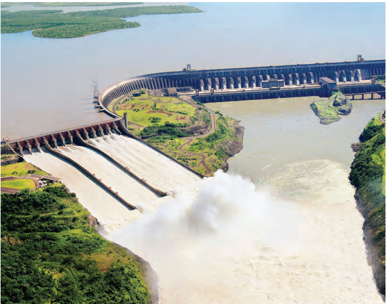
Vertedouro da hidrelétrica de Itaipu. Itaipu Binacional / Caio Coronel
