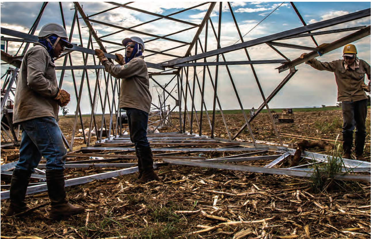
Manutenção em linha de transmissão. Eletronuclear Furnas / Daniela Monteiro
