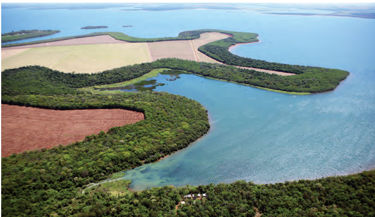
Faixa de Proteção. Itaipu Binacional / Alexandre Marchetti
